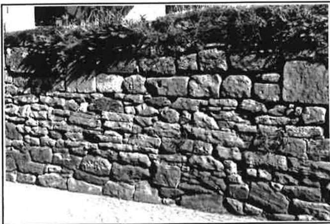
Hofmauer aus Bruchsteinen (Rotsandstein) in Trockenbauweise
