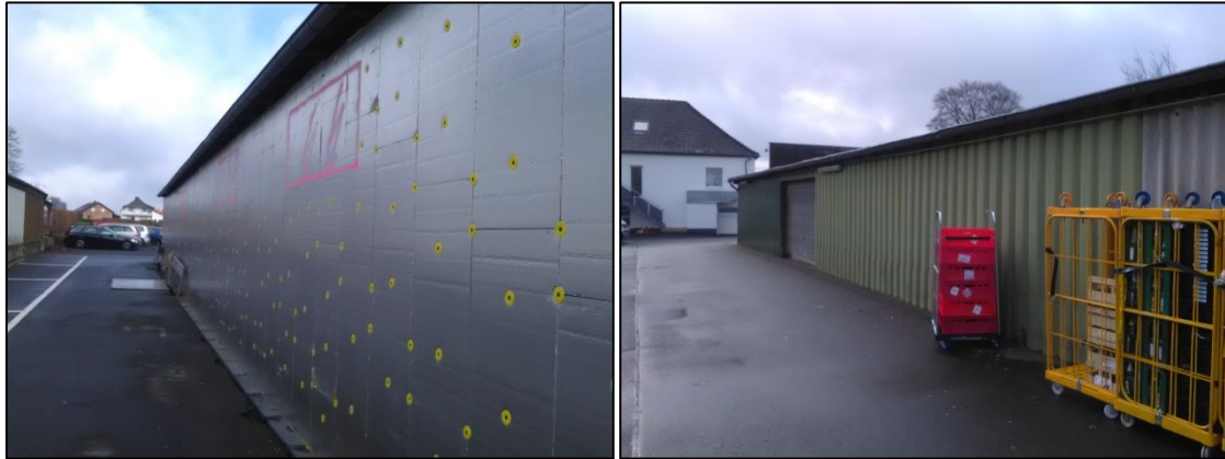
Abb. 3a/b: Blick auf die Westmauer (links) und die Ostmauer (rechts) des Nahversorgungsmarktes.
